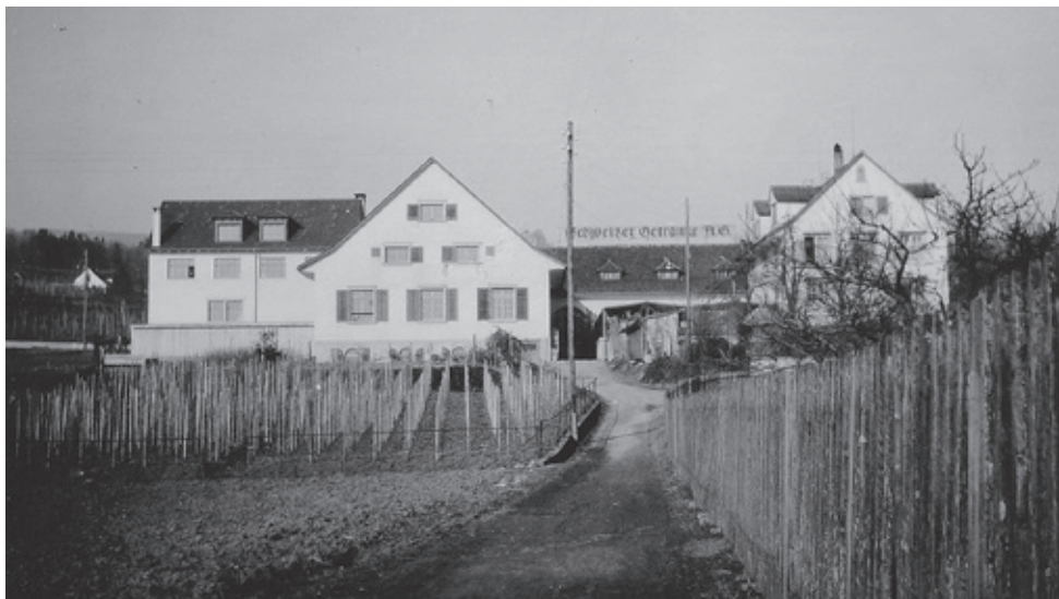
Fabrikgelände, undatiert, vermutlich 1930er Jahre. Rechts das erworbene Haus, links das neu erbaute Fabrikationsgebäude
