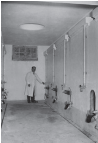
Betontanklager im Jahre 1962. Jeder der 8 Tanks hat ein Fassungsvermögen von 5000 Litern.
