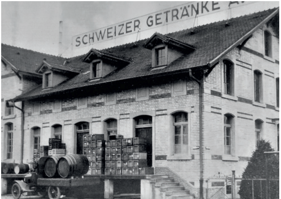
Geschäftsgebäude in Männedorf, an der Seestrasse, 1920er Jahre
