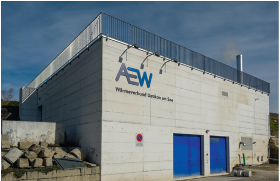
Die Zentrale der Fernwärme steht an der Ecke Alte Landstrasse/Keuzsteinstrasse und nahm 2014 ihren Betrieb auf
