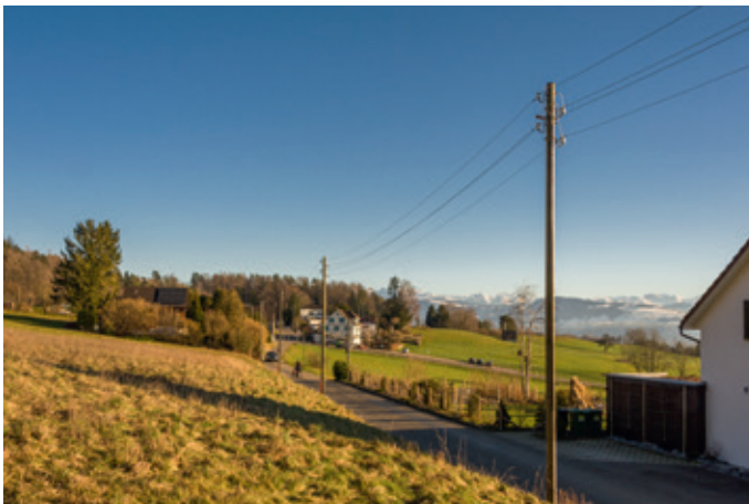
Freileitungen für die Stromversorgung mit nicht isolierten Drähten sind Zeugen einer vergangenen Zeit und in Uetikon nicht mehr anzutreffen
