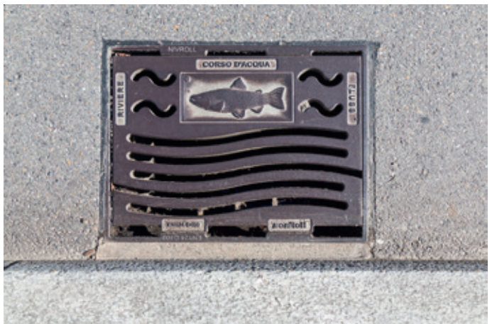
Meteorwasserleitung im Kleindorf
