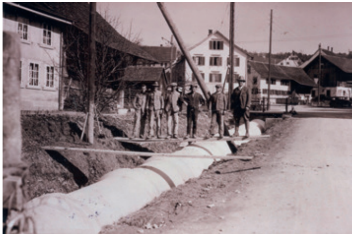
Bauarbeiten zur Eindolung des Kleindorfbachs, 1933
