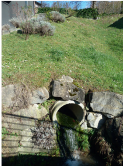
Der Rundibach soll an der alten Bergstrasse wieder freigelegt werden (Projekt 2020)
