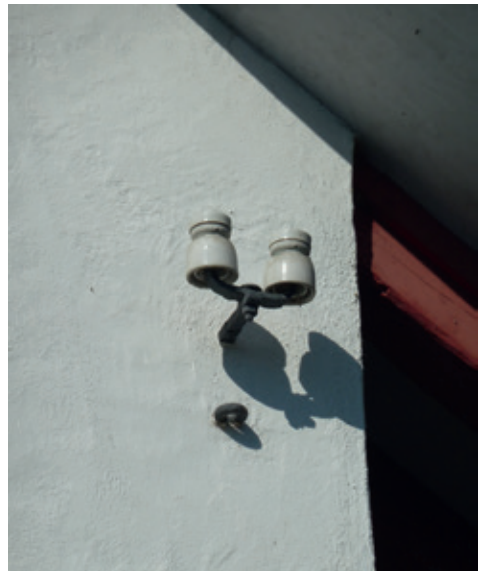
Bei einigen älteren Häusern sind noch die Isolatoren der früheren Telefonleitungen sichtbar
