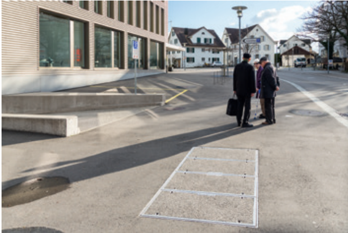
Viereckige Deckel schliessen die unter- irdisch verlaufenden Stromkabelstränge ab
