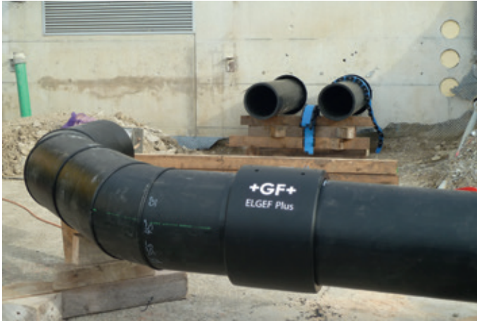
Die neuen Ansaugrohre wurden im Frühling 2020 an die Zentrale angeschlossen. Die Fernwärme wird neu mit dem Energieinhalt des Seewassers erzeugt.
