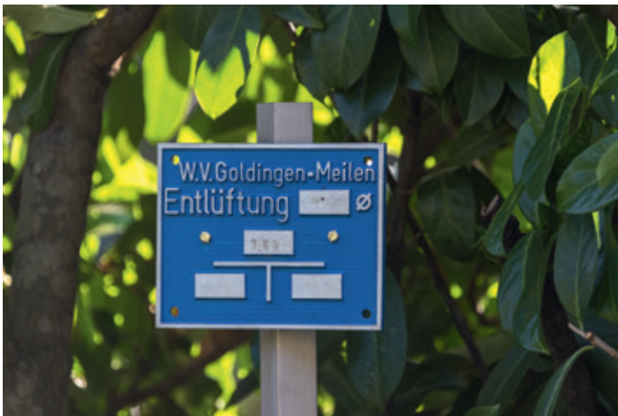
Hinweistafel zur Entlüftung der Goldingerleitung an der Brähenstrasse
