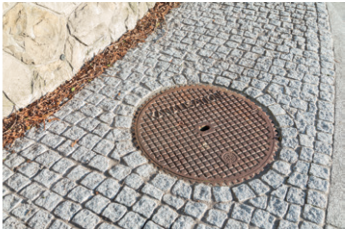
Kanalisationsdeckel beim Rankweg
