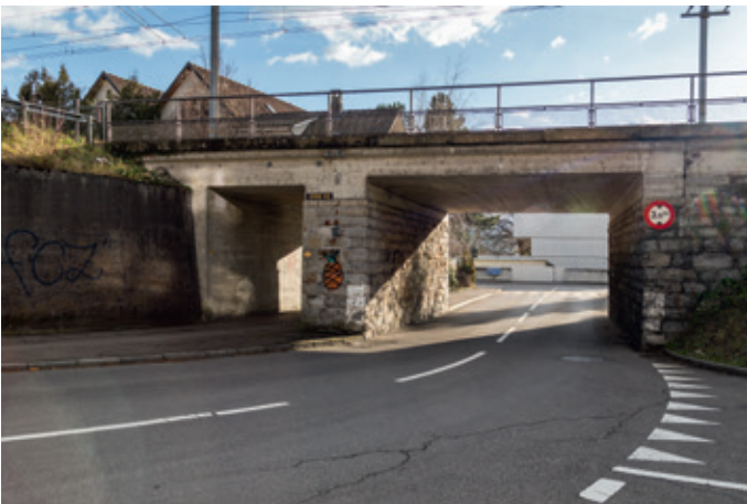
Die Bahnunterführung zur Seestrasse wurde in den letzten 100 Jahren mehrmals umgebaut und verbreitert
