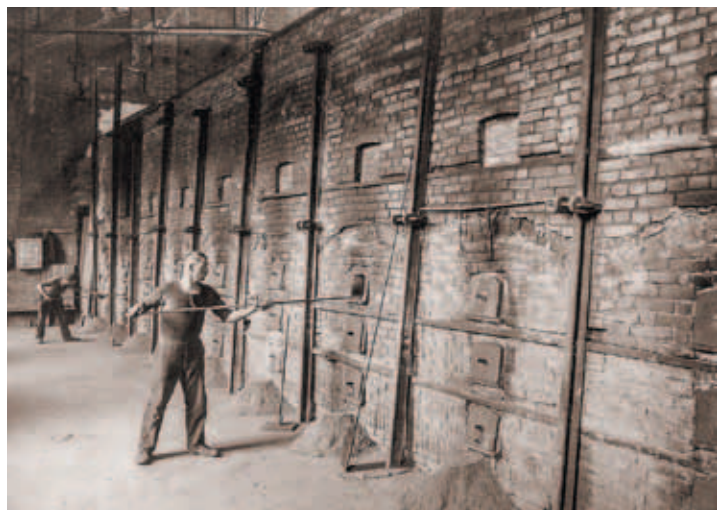
Im 19. und zu Beginn des 20. Jahrhunderts erforderte das Bedienen des Pyritofens anstrengende Handarbeit
