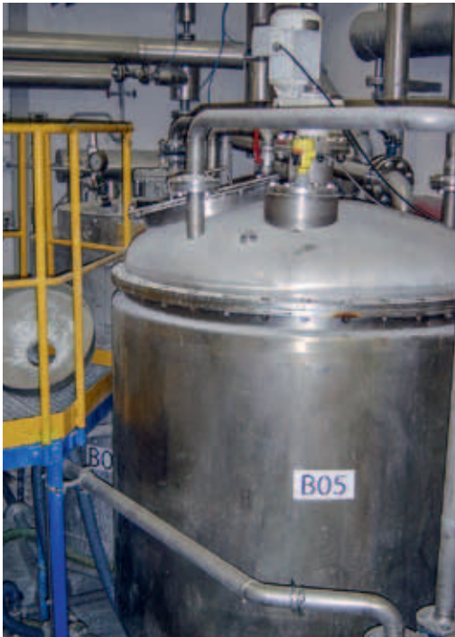
Mit einem kleinen Reaktor von 1500 L Inhalt wurde 1972 die Zeolithproduktion aufgenommen
