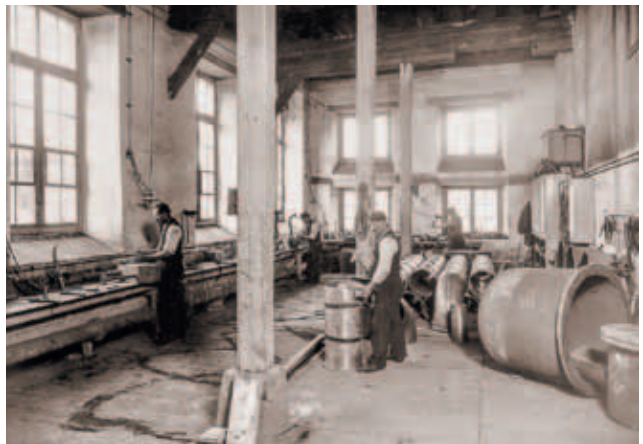
Für die Herstellung der Bleikammern wurden spezialisierte Bleilöter angestellt (Aufnahme 1904)
