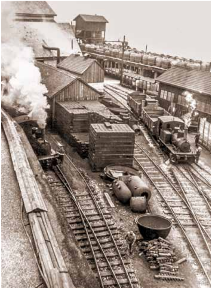
Gleisanlage beim Salzsäurebetrieb im Jahre 1910
