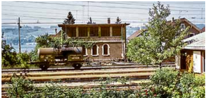
Das Stellwerkgebäude wurde 1970 abgebrochen
