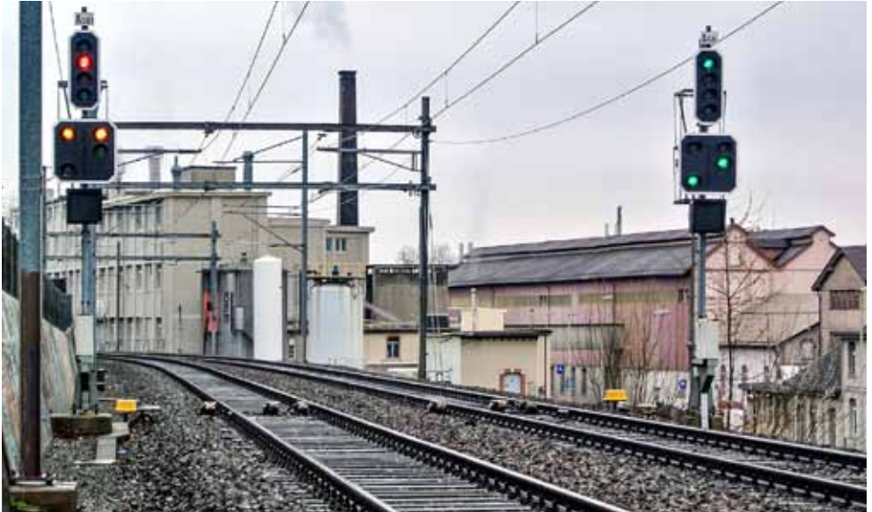
Das Signalsystem des Typs L bei der Einfahrt in Uetikon von Meilen herkommend
