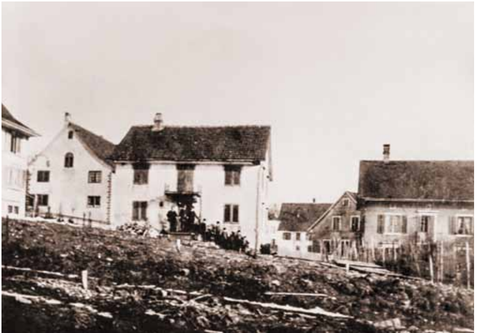
Die Häuser der Geschwister Lütold (Mitte) und die Krone (rechts) wurden abgebrochen
