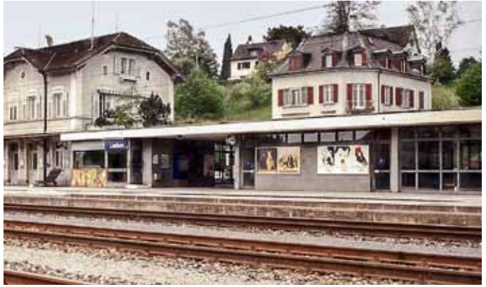
Neubau Büro und Wartesaal
