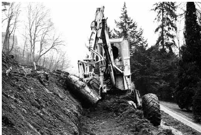
Hydraulikbagger zum Ausheben der Kleinterrassen
