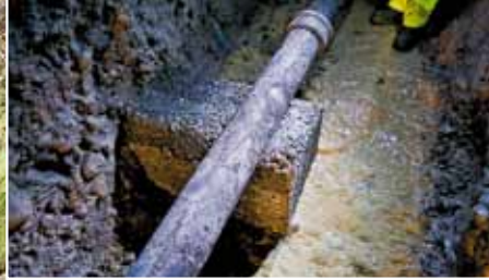
Quellableitung im Stollen
