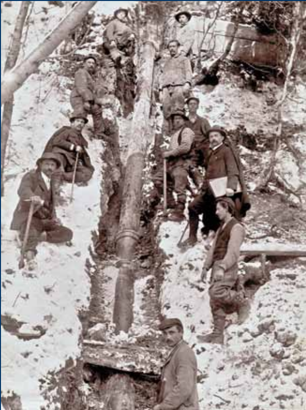
Kommission und Arbeiter im Goldingertobel beim Bau der Leitung
