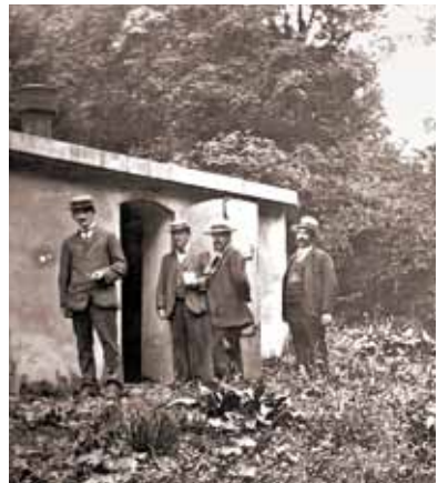
vor der Sammelbrunnenstube
