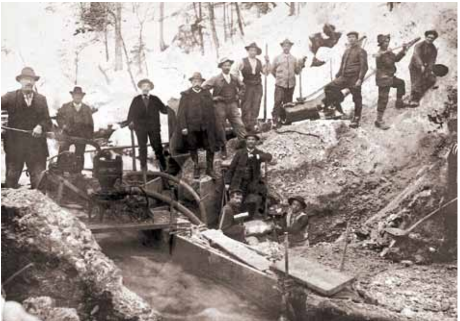
Arbeiter im Tobel
