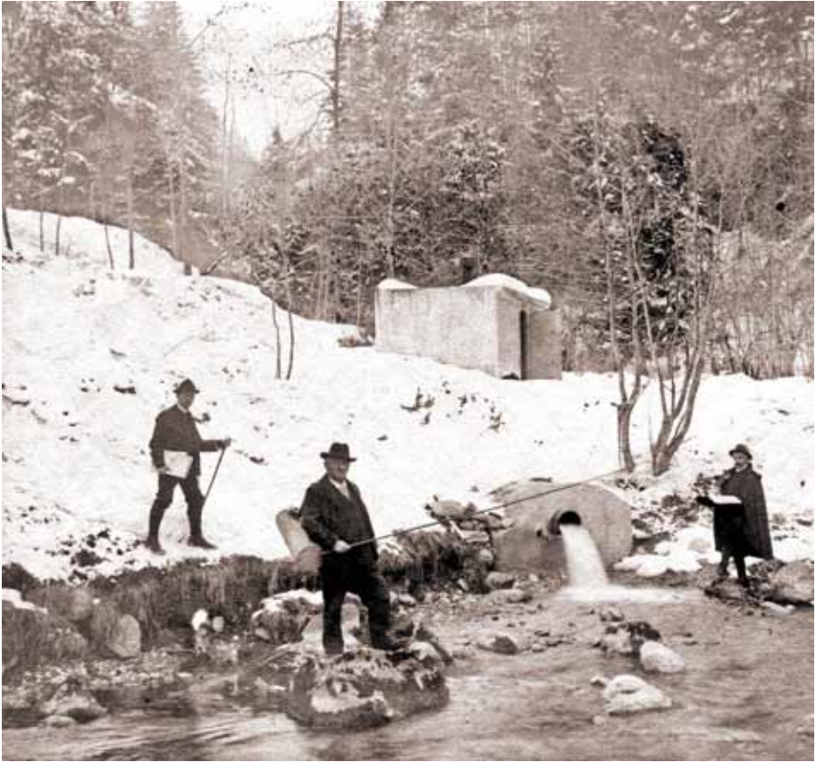
Bauleiter vor Sammelbunnenstube
