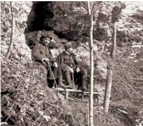
Bauleiter Ingenieur Bosshard (rechts)
