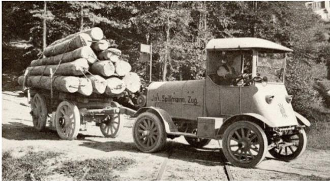
Vorspann-Wagen mit elektrischer Winde
