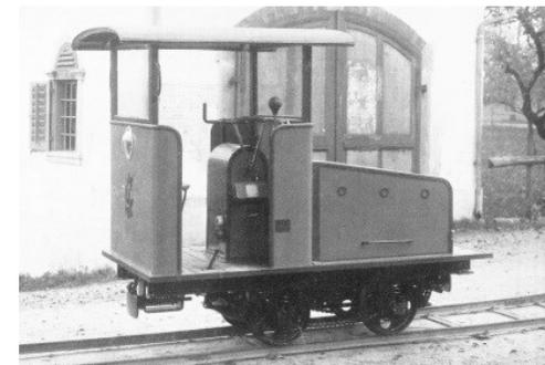
Rollbahnlokomotive, Zuglast von 5-15 Tonnen
