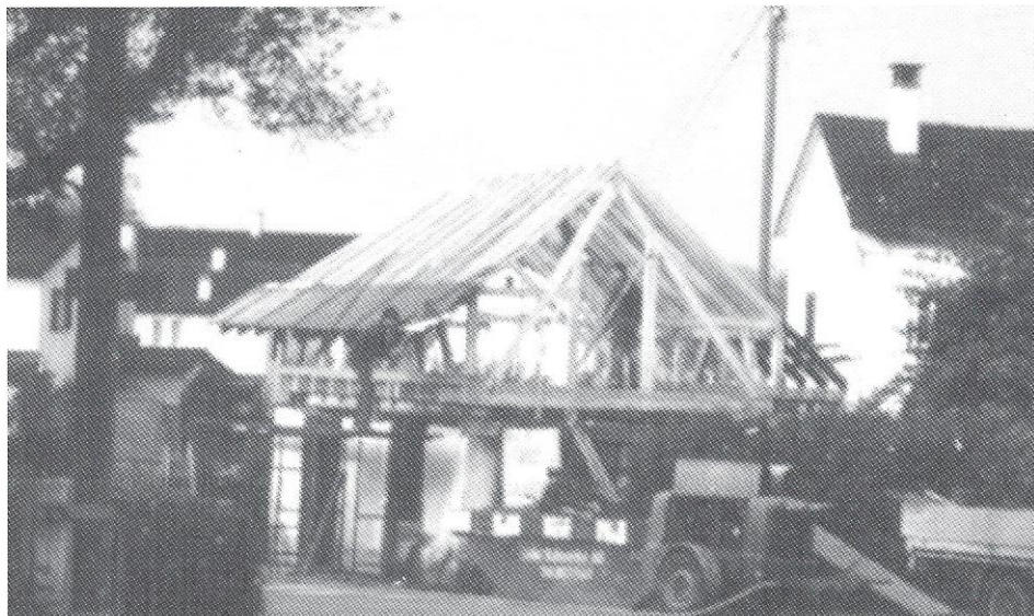
"Wöschhüsl" Grossdorf wird umgebaut zur WC- und Trafo-Anlage 1983
