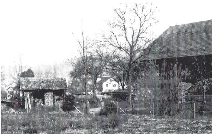
Schöpfli und Scheune Bauernhaus Steiger Kleindorf
